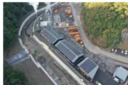
木質バイオマス施設
