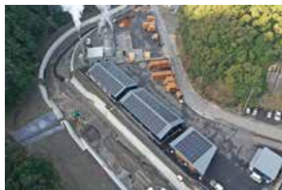
木質バイオマス施設
