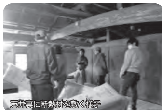
天井裏に断熱材を敷く様子
