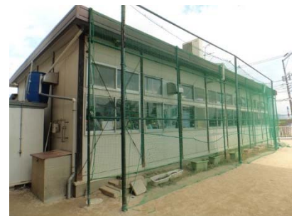
写真：うのクラブ外観 (緑のカーテンネット・左に雨水タンク)
