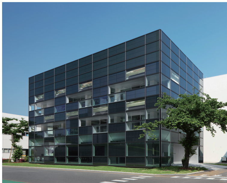
大成建設 ZEB 実証棟
