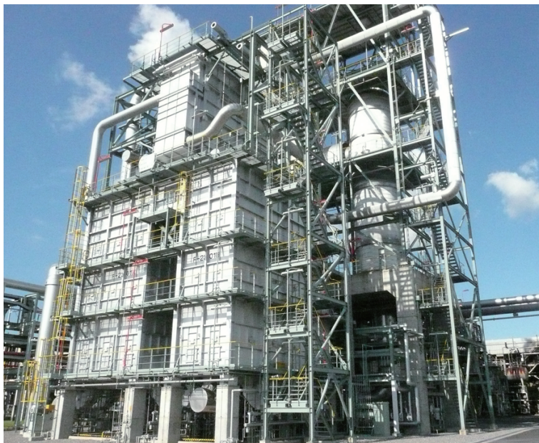
NS スチレンモノマー（株）の最新鋭スチレン製造プラント
