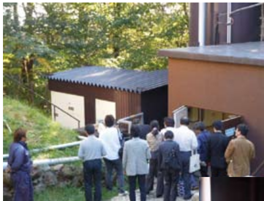
ヒートポンプ施設
