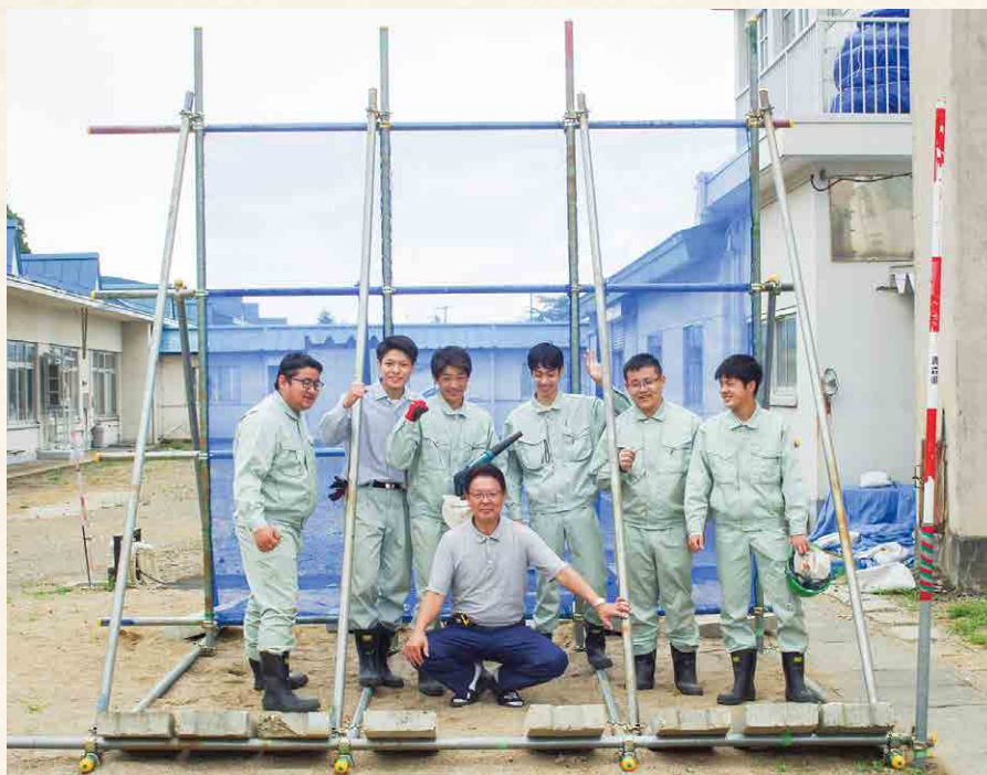
▲ 地中熱融雪装置システムのビニールハウスの骨組みと学生
