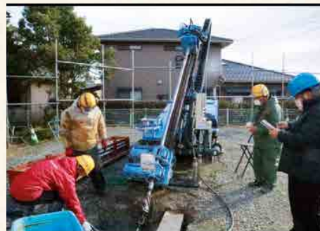
▲ 地中熱を利用するための掘削工事
