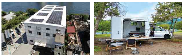
▲ 遮熱塗料を施した屋根と太陽光発電パネル
