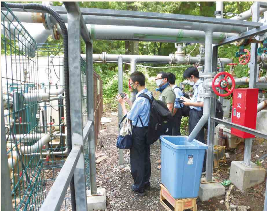
▲ 温泉施設に導入されたバイナリー発電を見学
