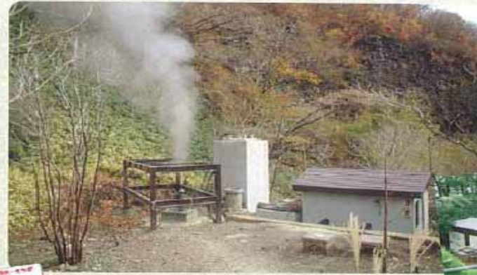
風呂にヒートポンプ設備、手前がボイラー設備。 ボイラー設備も補助設備として残している。
