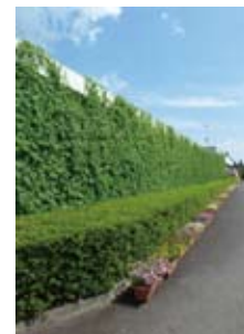
事務所棟西側の窓に長さ53m、高さ4.5mのゴーヤによるグリーンカーテンを設置
